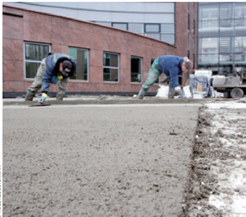
Aanbrengen C-eps mortellaag.
